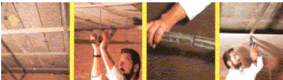
Figura XVI.13 – Execução de tectos contínuos.
