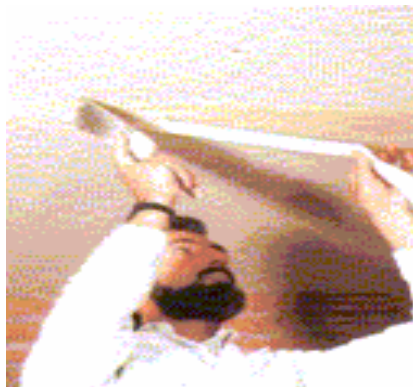
Figura XVI.14 – Execução do tratamento de juntas.
