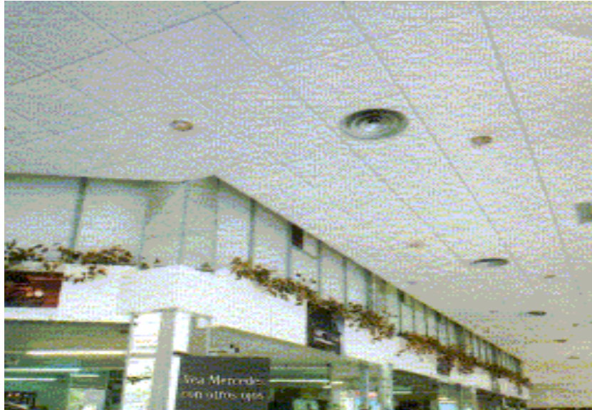
Figura XVI.19 – Aspecto de um tecto em placas de gesso aligeirado com fibras.
