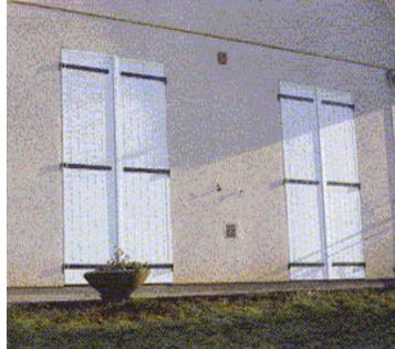
Figura XIV.6 – Portada com painel cego de 23 mm
