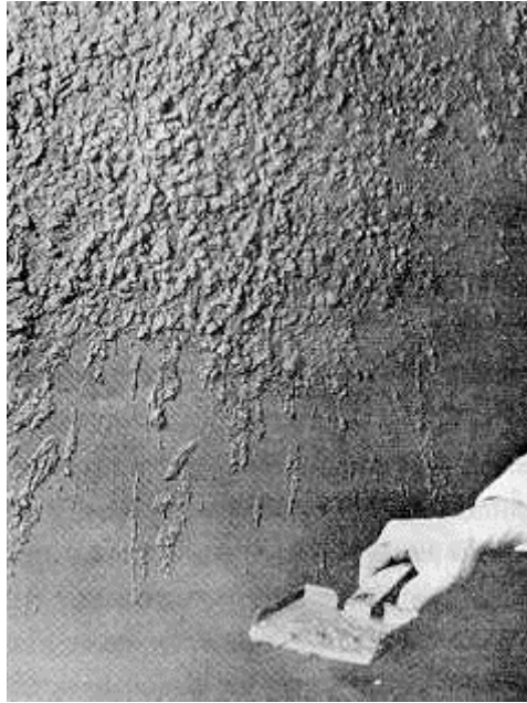
Figura IX.1 - Execução de acabamento Escocês
