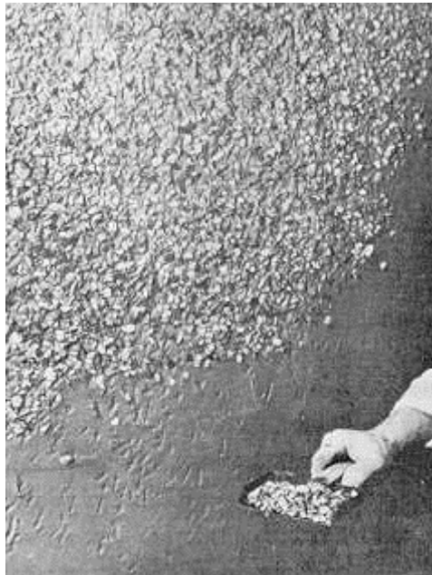
Figura IX.2 - Execução de acabamento seixo à vista
