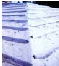
Figura IV.6 – Ripado de argamassa sem cortes para ventilação
