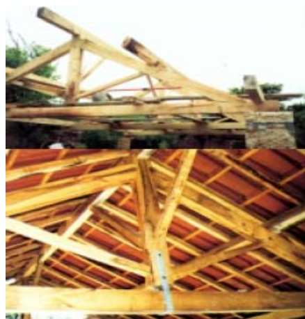
Figura IV.4 – Asnas de madeira durante e após a construção
