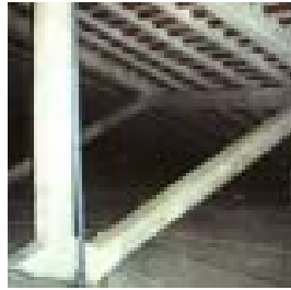
Figura IV.5 – Asnas em betão armado
