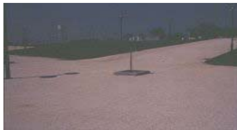
Nó Ferroviário Norte/Sul – Estação Fogueteiro – Mod. 260 - PROFABRIL
