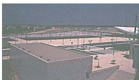
Nó Ferroviário Norte/Sul – Estação Corroios – Mod. 260 - PROFABRIL
