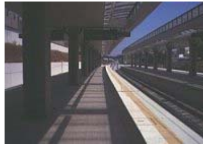
Eixo Ferroviário Norte/Sul Estação Corroios
