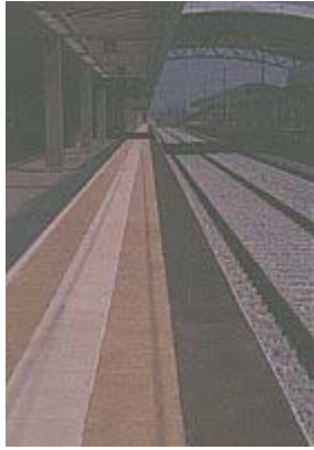
Eixo Ferroviário Norte/Sul Estação Corroios
