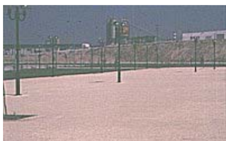
Nó Ferroviário Norte/Sul – Estação Corroios – Mod. 260 - PROFABRIL
