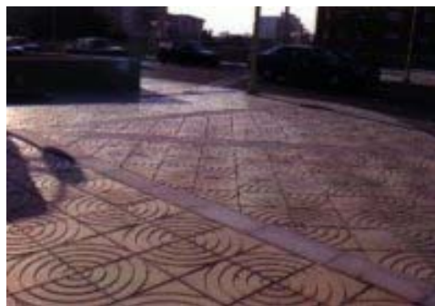
Viaduto Boavista (Porto) relevo polido
