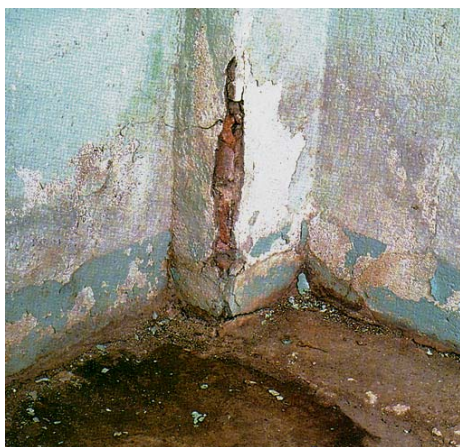
Figura XIII.2 – Patologia em revestimento de parede por ascensão capilar de água.
