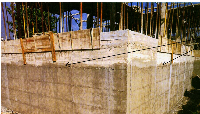
Figura XIII.6 – Parede de betão armado não impermeabilizada
