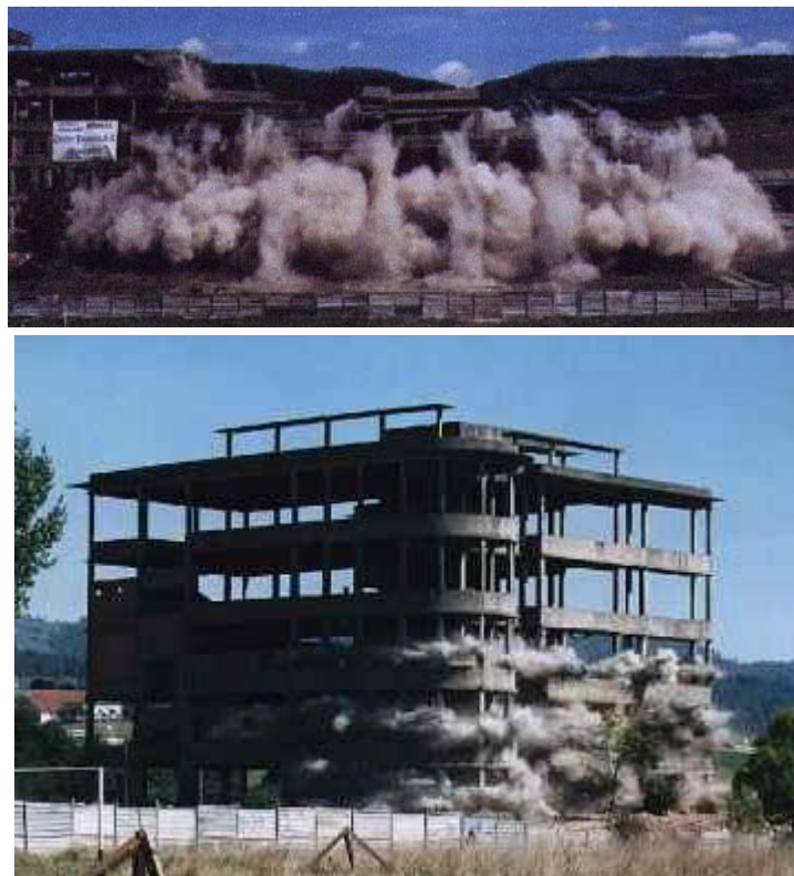
Figura I.6 – Demolição por explosão controlada
