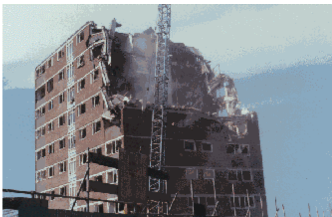
Figura I.5 – Demolição com massa metálica suspensa
