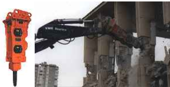
Figura I.8 – Demolição com martelo hidráulico
