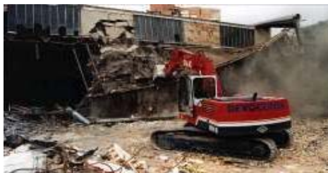
Figura I.4 – Derrube por impulso lateral
