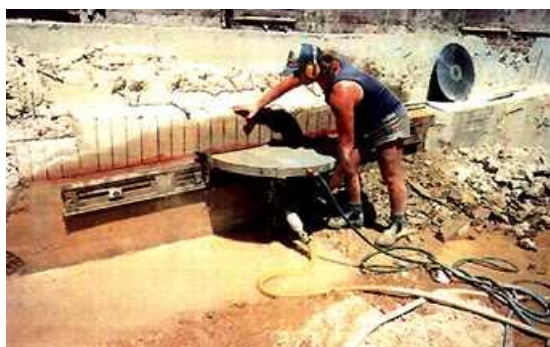
Figura I.9 – Demolição com serra de corte
